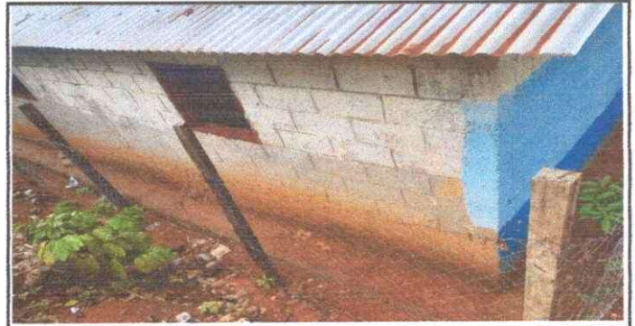
Foto 6: Colocacion de Muros: Mejoraremos el muro Perimetral.
