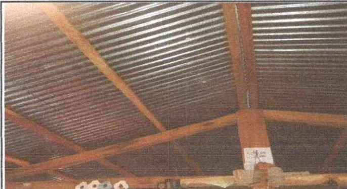
Foto 3: Sustitucion de Vigas y Costaneras.
